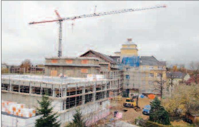
Anfang November wurde die Außenisolierung an der Turnhalle angebracht. Ziel ist es den Bau vor dem ersten Schnee von außen zu schließen, um innen für eine Grundwärme zu beheizen.
